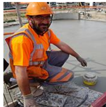
8 Un ouvrier de Bouygues BTP en plein travail
